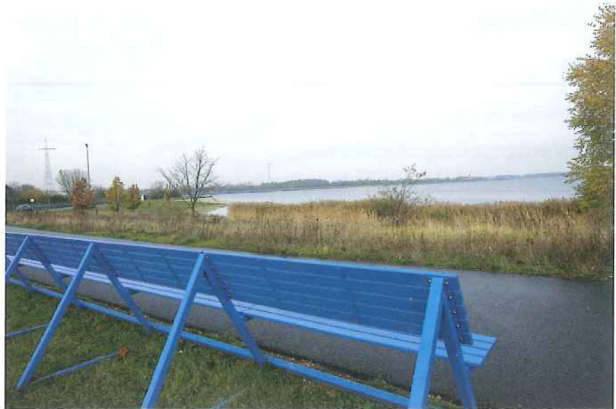
Das gegenwärtig laufende Bauvorhaben „Verkehrstechnische Erschließung Bitterfeld-Süd“ dient neben der Innenstadt-Verkehrsentlastung und der besseren Erreichbarkeit der hier ansässigen Unternehmen insbesondere dem touristischen Verkehr zur Goitzsche.
